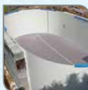
3 Utläggning av botten-skyddsmatta, botten-skenor och montering av stål-väggen med profilerad skena
