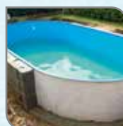
5 Efterfyllning av magerbetong
