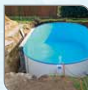
4 Inhängning och utjämning av linern. Montering av inbyggnadsdelar
